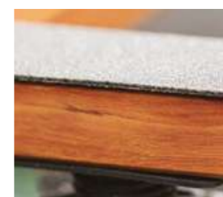
Lambourde posée sur sa grande largeur
